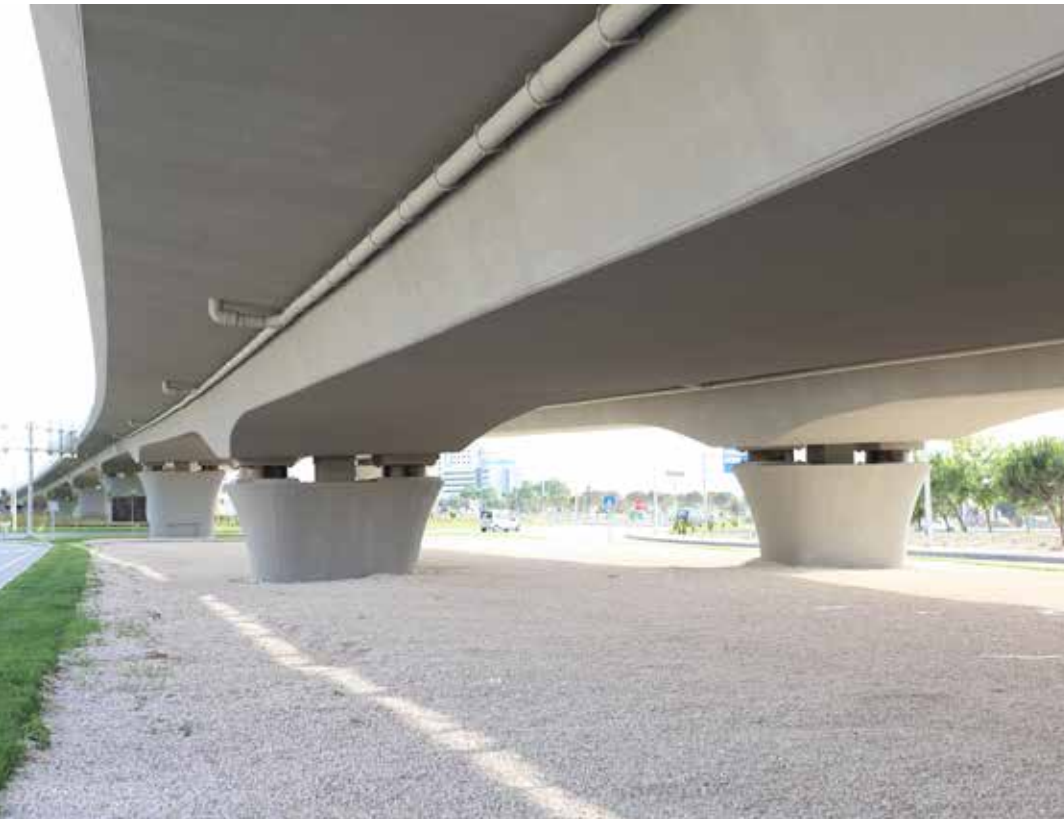
ALİBEYKÖY METRO GEÇİŞ KÖPRÜSÜ | İSTANBUL/TÜRKİYE Yerinde Döküm Metodu / Ardgerme ALİBEYKÖY METRO CROSSING BRIDGE | İSTANBUL/TURKEY Cast-in-Situ Method / Post-tensioning
