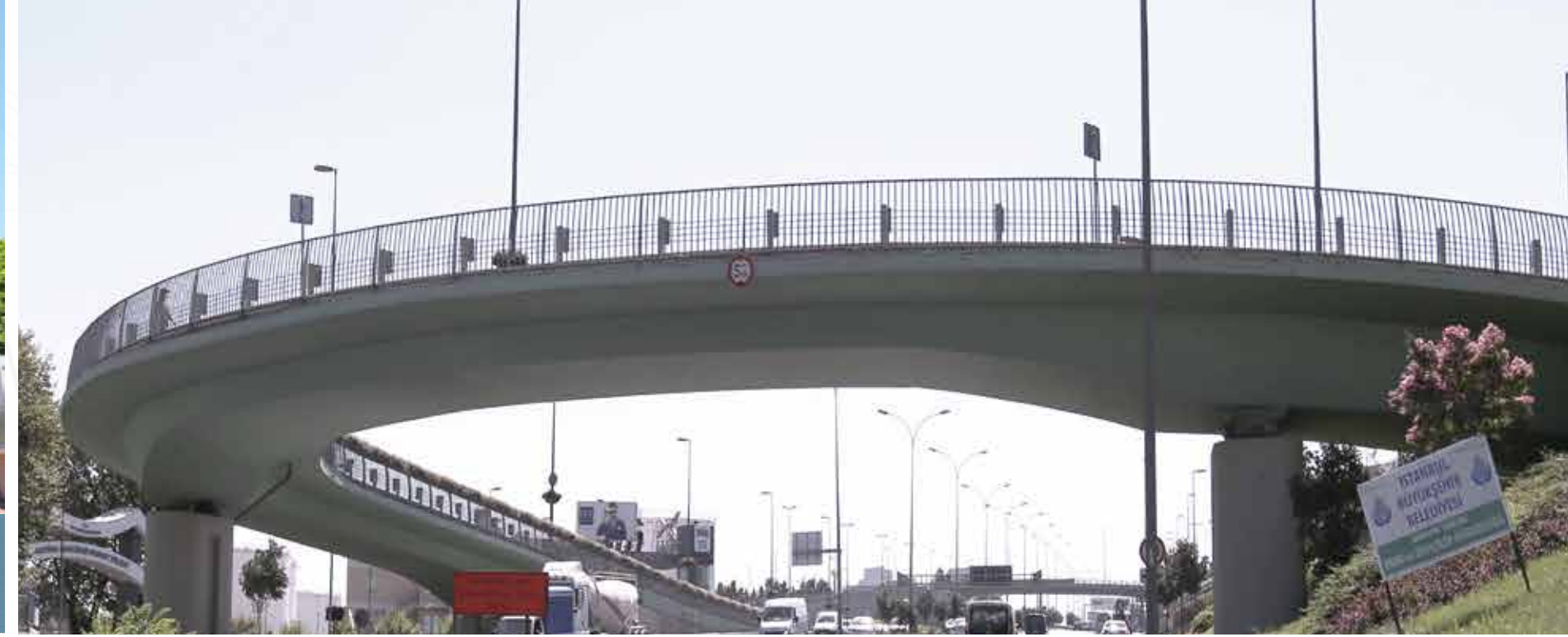
MEVLANA KÖPRÜSÜ | ANTALYA/TÜRKİYE Yerinde Döküm Metodu / Ardgerme MEVLANA BRIDGE | ANTALYA/TURKEY Cast-in-Situ Method / Post-tensioning
