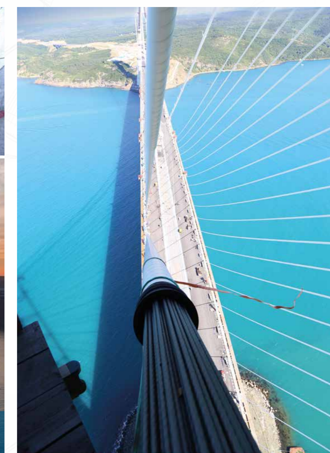
YAVUZ SULTAN SELİM KÖPRÜSÜ | İSTANBUL/TÜRKİYE Eğik Askı / Ağırlama Metodu YAVUZ SULTAN SELİM BRIDGE | İSTANBUL/TURKEY Stay Cable / Post-tensioning Method
