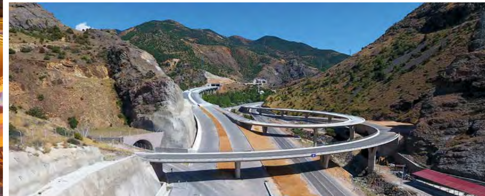
HACİEMİN 1-2 VİYADÜKLERİ | GÜMÜŞHANE/TÜRKİYE Yerinde Döküm Metodu / Ardgerme HACİEMİN 1-2 VIADUCTS | GÜMÜŞHANE/TURKEY Cast-in-Situ Method / Post-tensioning
