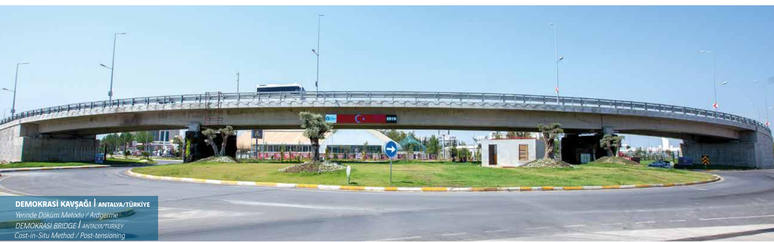
MEVLANA KÖPRÜSÜ | ANTALYA/TÜRKİYE Yerinde Döküm Metodu / Ardgerme MEVLANA BRIDGE | ANTALYA/TURKEY Cast-in-Situ Method / Post-tensioning
